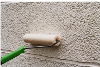
Graffitischutz PROWALL II auf Wandfläche applizieren, z.B. mit Roller.
