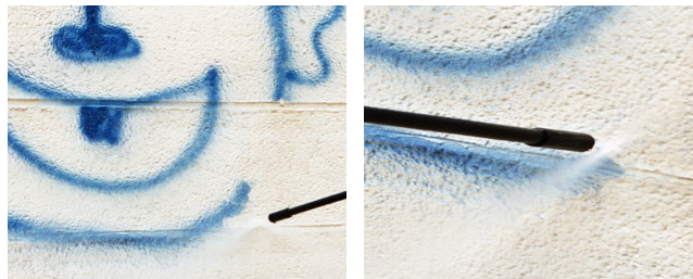
Bei Graffiti-Verschmutzung: Fläche mit Hochdruckreiniger reinigen. Danach gereinigte Fläche wieder neu mit PROWALL II beschichten.
